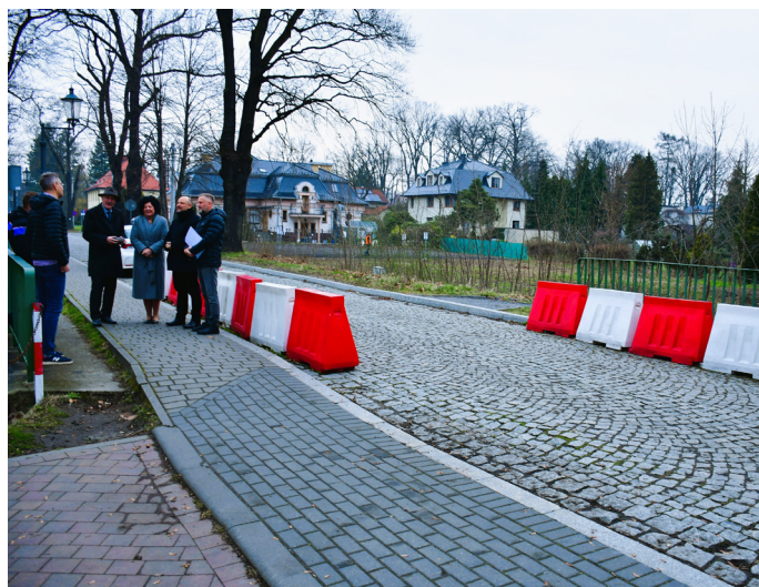
UG Przekazanie placu budowy odbyło się początkiem kwietnia (Fot. UG)
