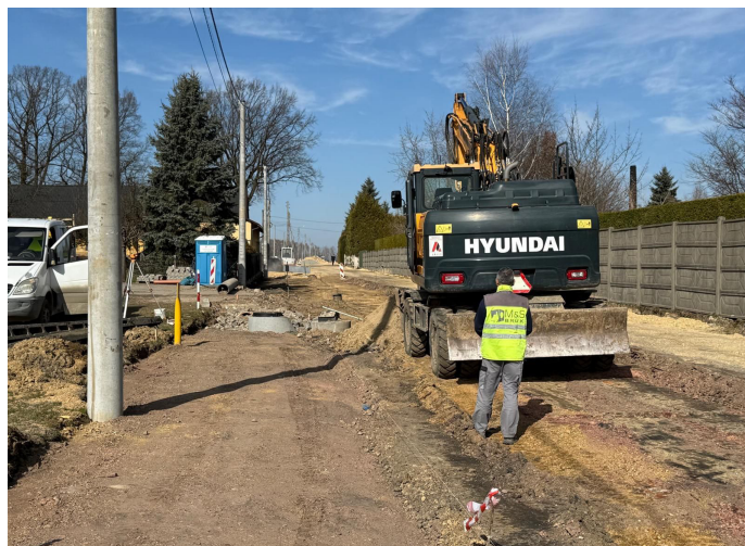
UG ■ Prace na ul. Siedleckiej w ramach I etapu (Fot. UG)
